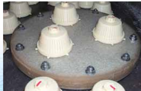
Internal Nozzle Plate Service Hatch/Trappe d'entretien interne du support de buse/Wartungsluke in Düsenplatte (innen)/Escotilla de mantenimiento de la placa de tobera interna
