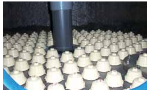
Nozzle Plate under drain system/Internal Nozzle Plate Service Hatch/Düsenplatte unter Ablass-System/Sistema de drenaje inferior de la placa de tobera
